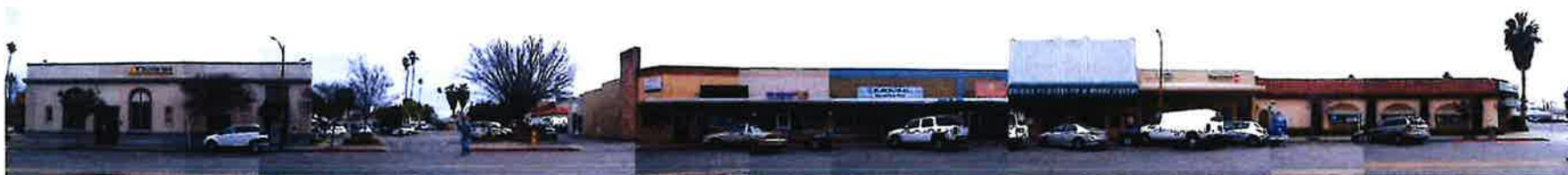
S. Del Puerto Avenue - east side.
